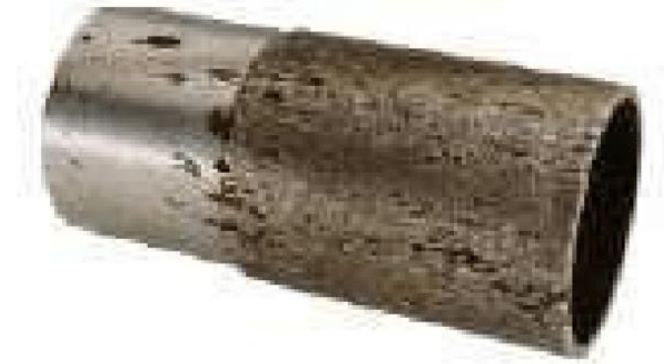
Figure I- 6 : Corrosion Par Piqures.
