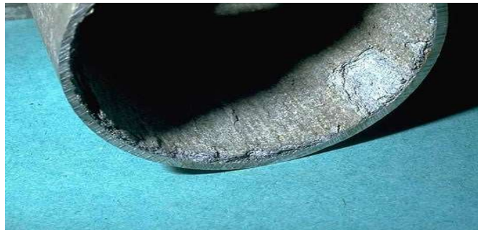
Figure I.8 Corrosion feuilletant d'une canalisation en alliage d'aluminium véhiculant de l'eau.
