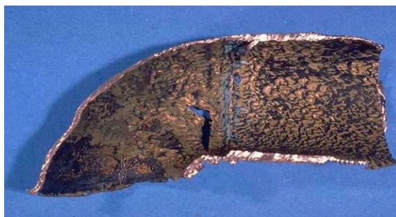
Figure I.10 Corrosion-érosion d'un tube en cuivre véhiculant de l'eau.
