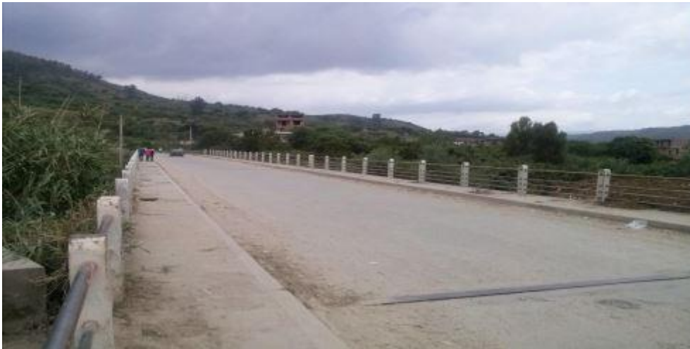
Figure.11 : Pont existant à la fin de projet
