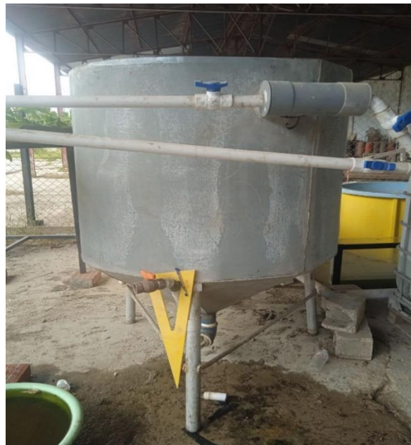
Figure II .9 : Système de filtration
