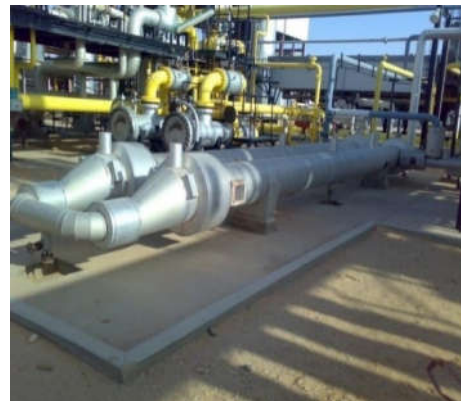
Figure IV.8 : Echangeur gaz-liquide E403A/B
