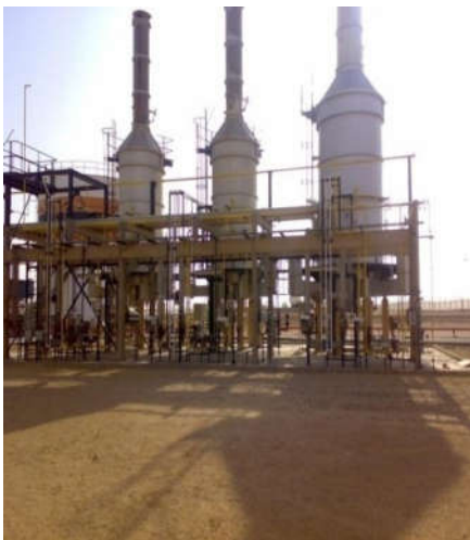
Figure IV.9 : Réchauffeurs H301A/B
