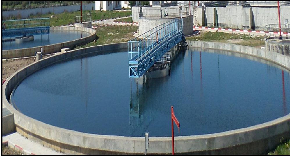
Figure III.12. Décanteurs Secondaires.
