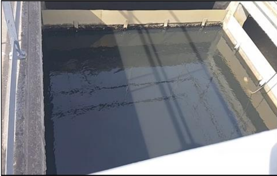
Figure III.7. Bassin de réception des eaux usées.
