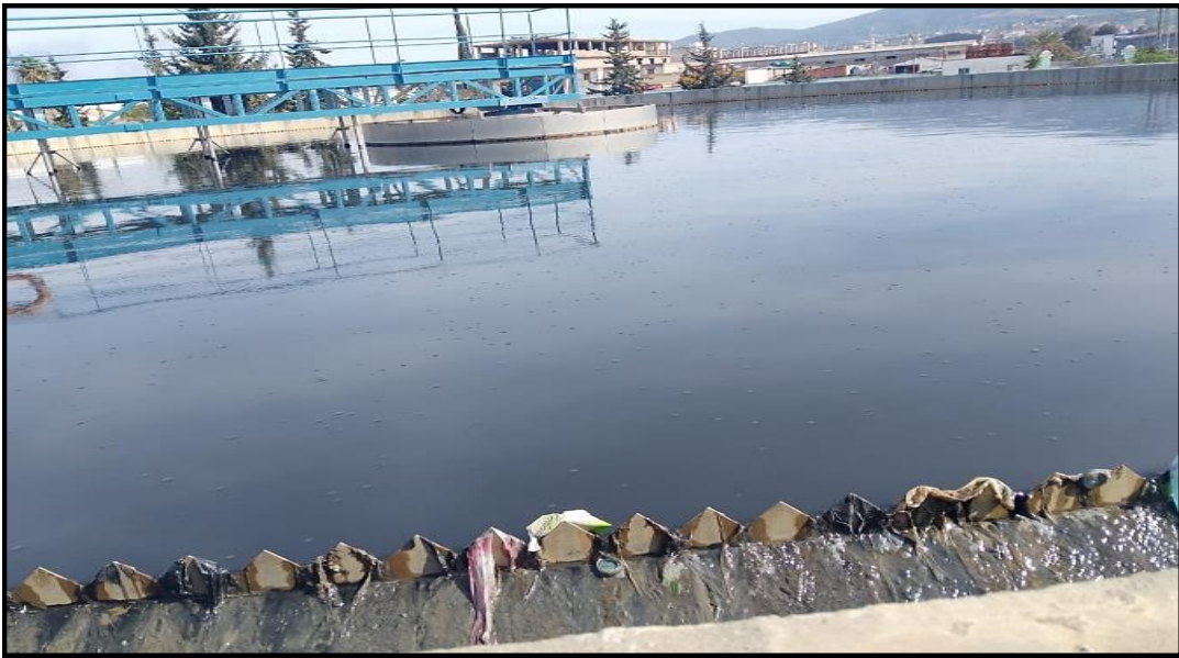
Figure III.11. Décanteur primaire.
