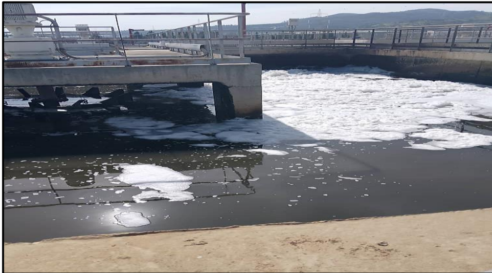
Figure III.13. Bassin d'aération.
