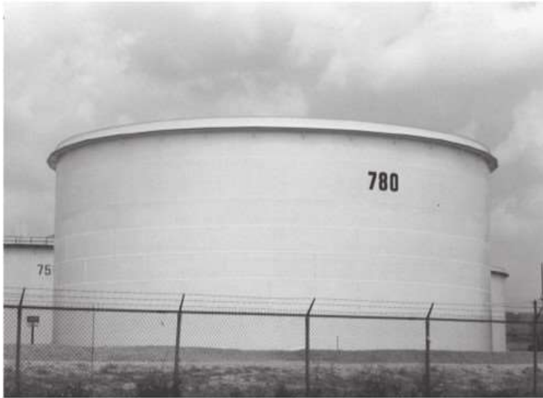
Figure I.8 : Les réservoirs cylindriques verticaux
