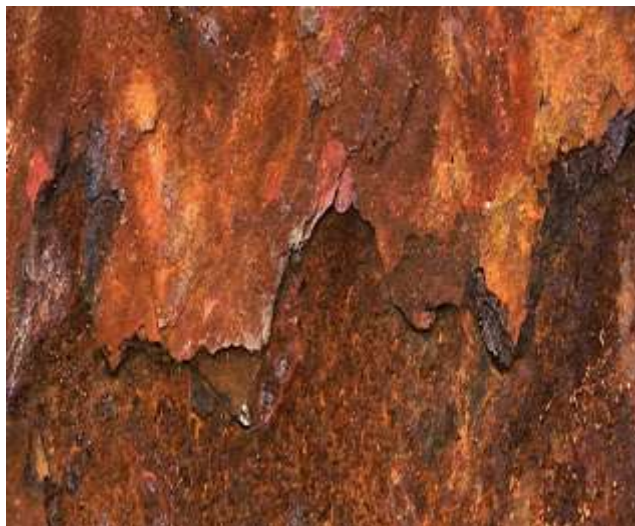
Figure II.2 : La corrosion chimique
