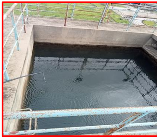
Figure I.2. Exemple Bassin brise de charge.
