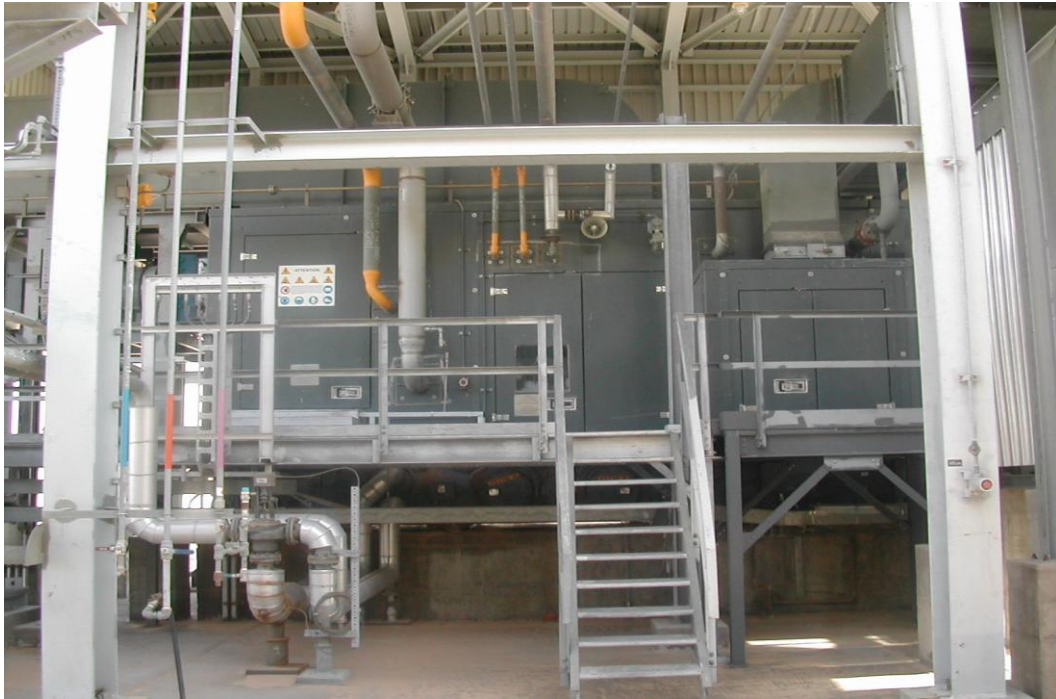
Figure I.1.7: Turbogénérateur / Turbine à gaz PGT10 (11W)
