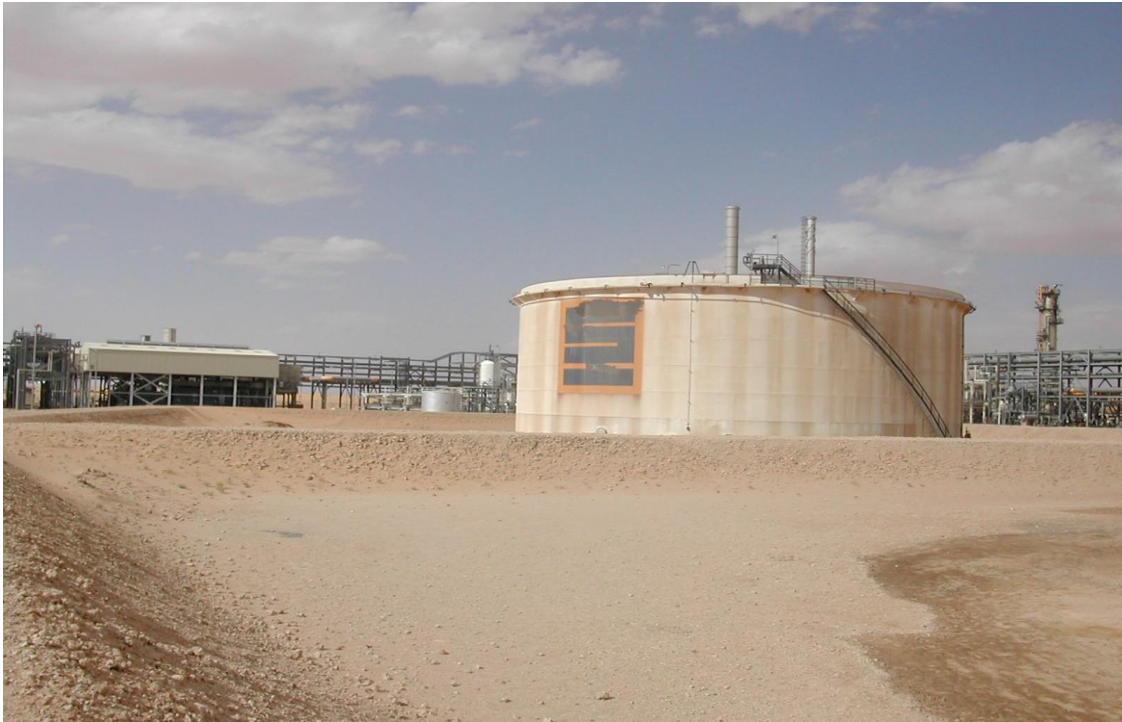
Figure I.1.8: Bac de stockage à toit flottant
