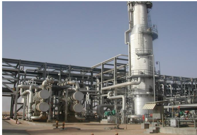
Figure I.1.5: Colonne de stabilisation haute pression
