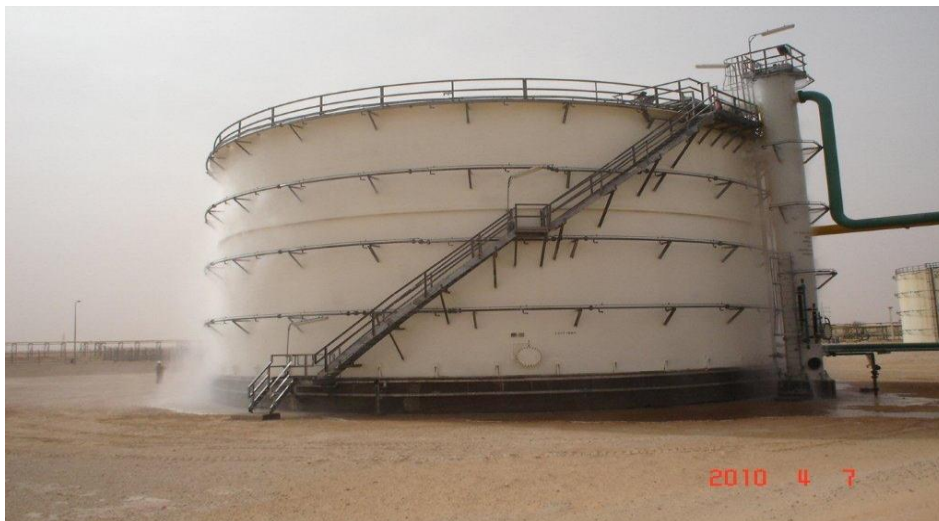
Figure I.7 : Bac de stockage d'huile avec un dégazeur.
