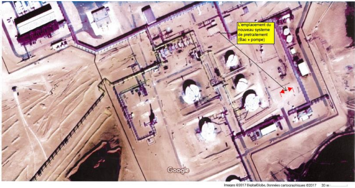
Figure IV.14 : L'emplacement du nouveau système de prétraitement proposé avant le cyclo-séparateur (vue de haut).
