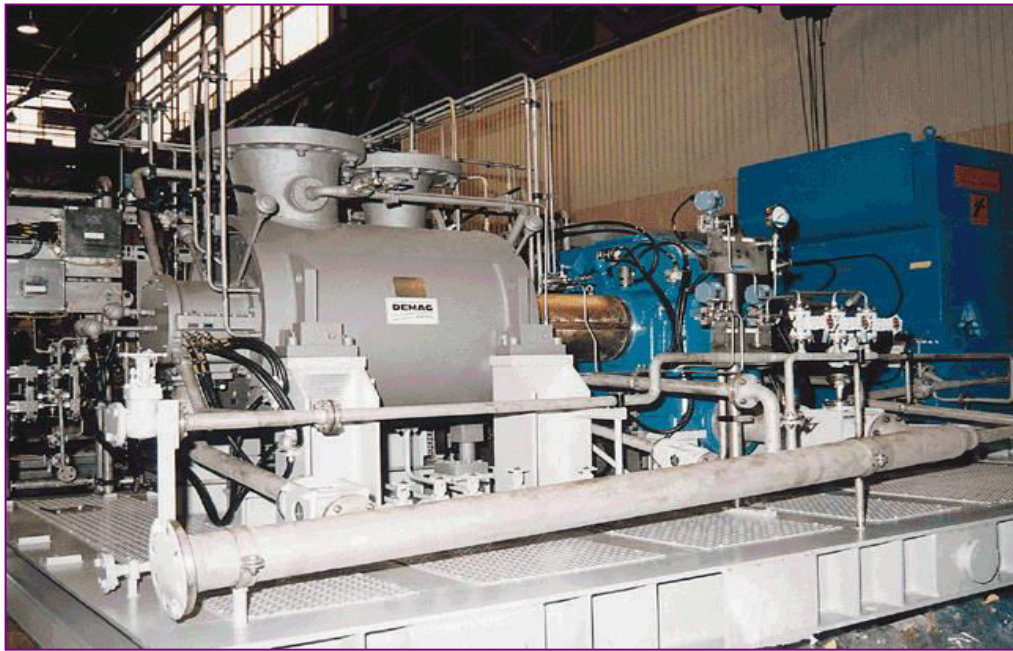
Figure II.12 Le Compresseur Centrifuge type Barrel-2
