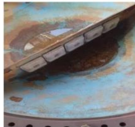
Figure I.18: photo réel des anodes sacrificielles
