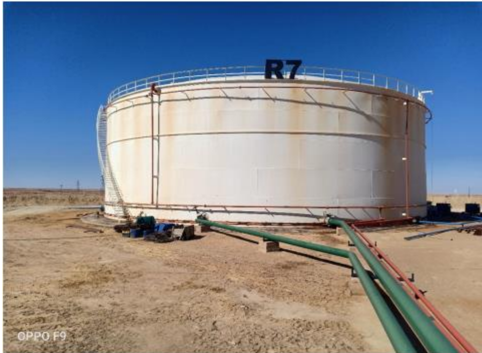
Figure I.4: Bac de stockage de brut dans La région TFT-Illizi Sonatrach.
