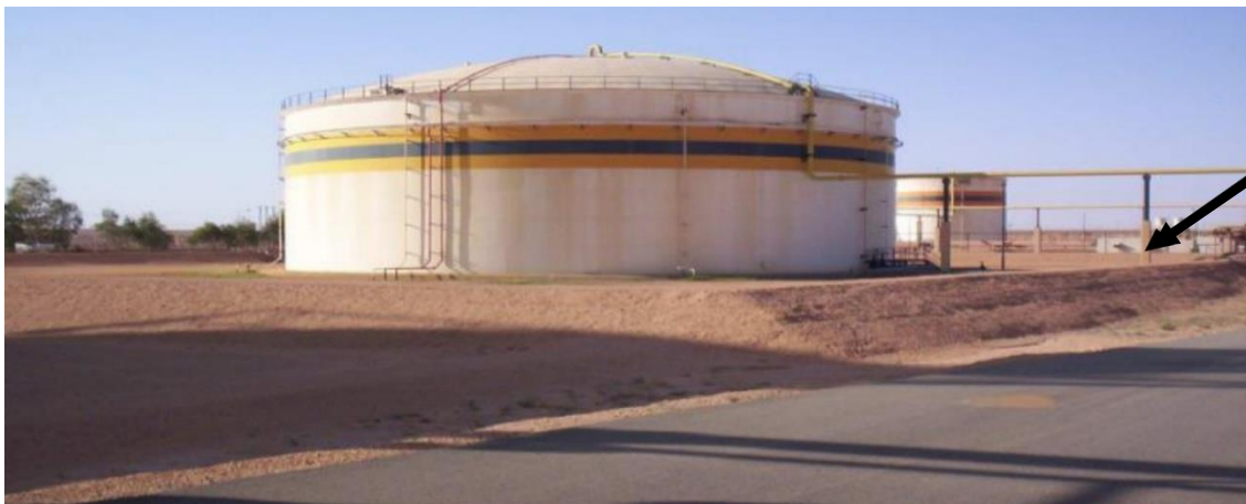
Figure 1.5 : Cuvette de rétention
