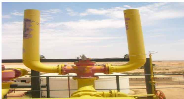
Figure 1.6 : Soupape de sûreté
