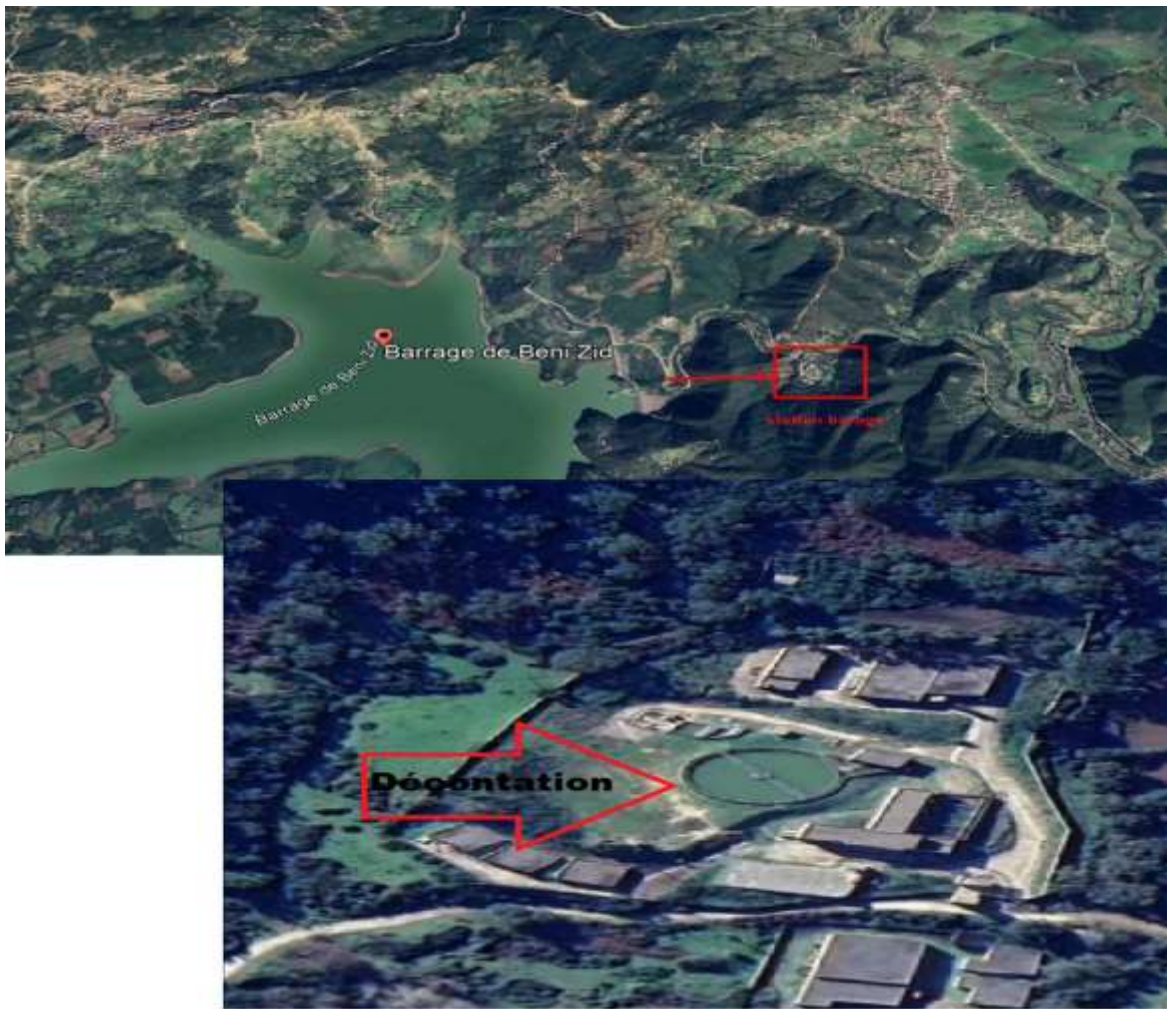
Figure II.3. Vue aérienne de la station de traitement Béni Zid.
