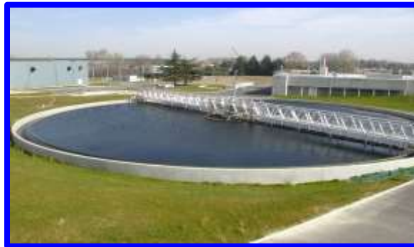
Figure I.5. Bassin de décantation
