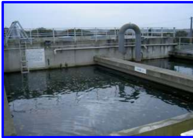
Figure I.7. Filtre à charbon -affinage
