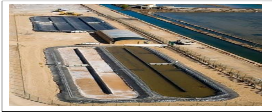
Figure 15 : Bassins construits dans le cadre du projet Salin algue à Gruissan.
