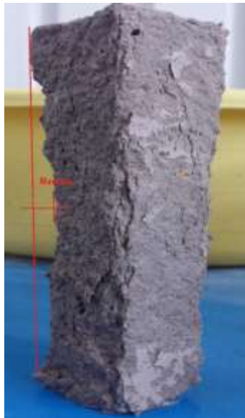
Figure IV.10: Dégradation d'une éprouvette de SD2 50% après 100 cycles de gel-dégel.
