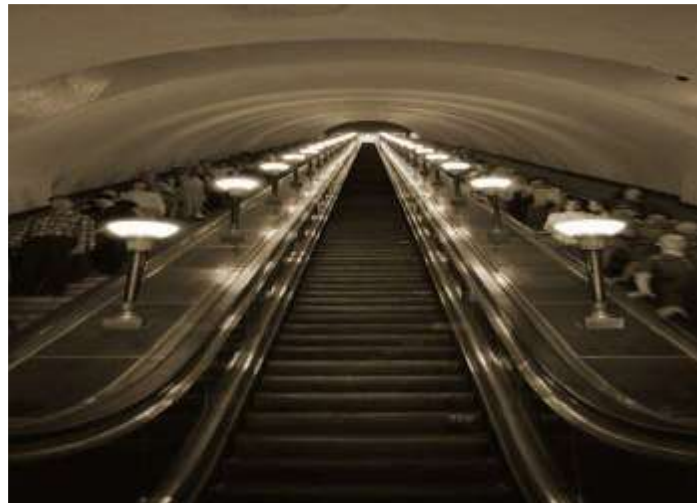
Figure I.3 : Métro de Saint-Petersbourg [SABLOCRETE, 1994].
