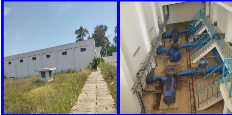
Figure II.18. Station de pompage avec trois pompes homogène
