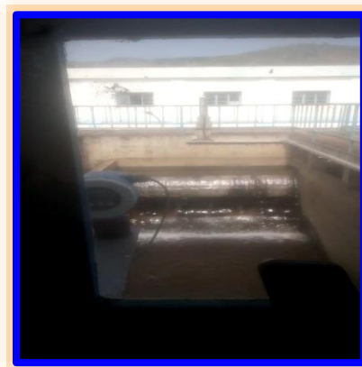
Figure II.15. Opération après le lavage des filtres
