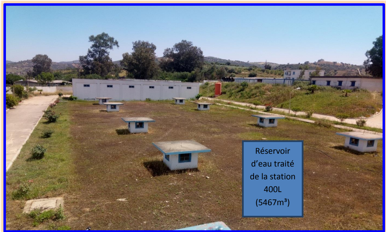
Figure II.17. Réservoir d'eau traité
