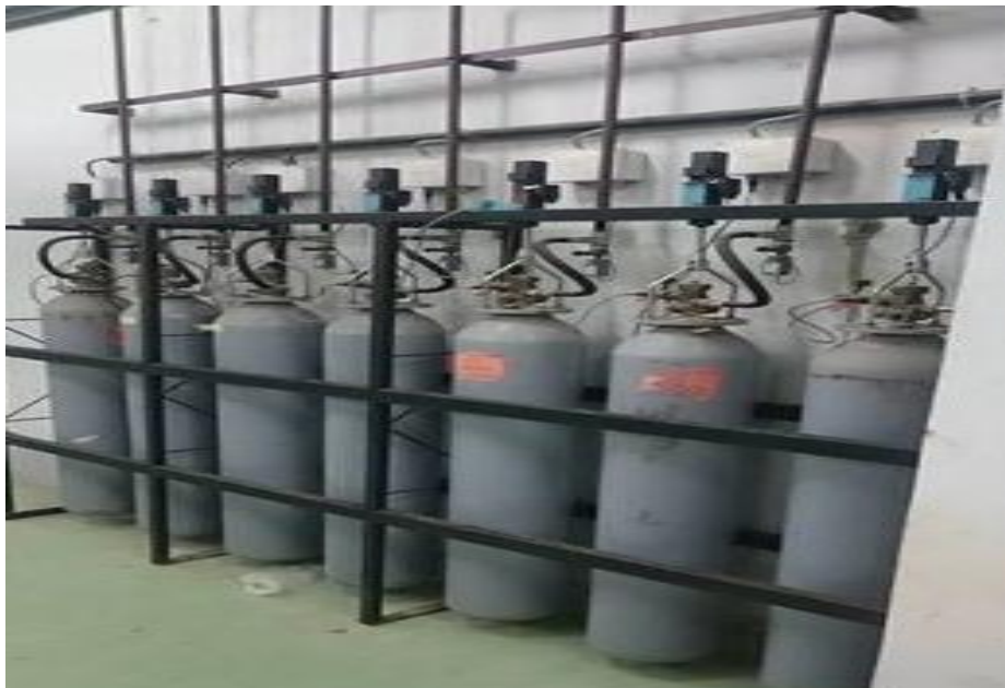
Figure III.9 : Système d'extinction à CO2
