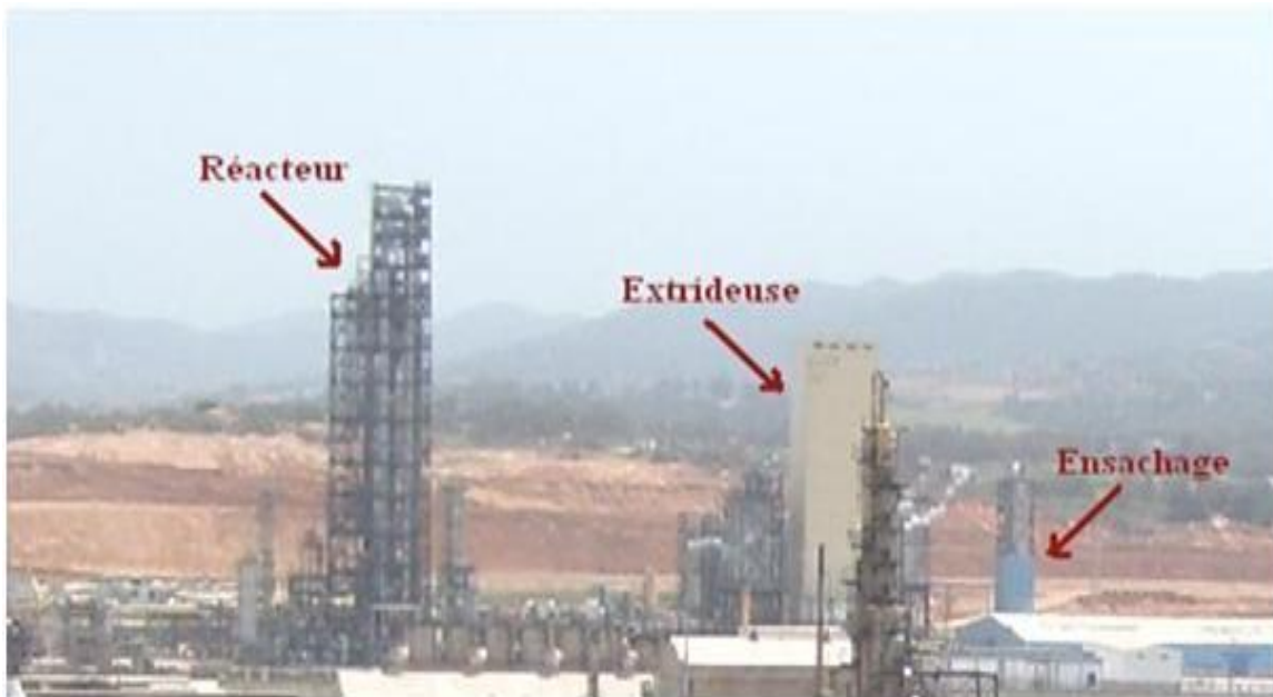
Figure III.3. Photo représente les principales installations de l'unité CP2K
