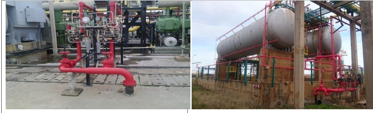
Figure III.7 : Système déluge
