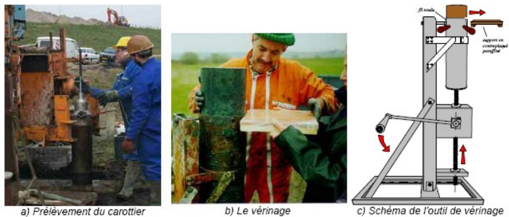
Fig I-15: Remontée du carottier et extraction des carottes
