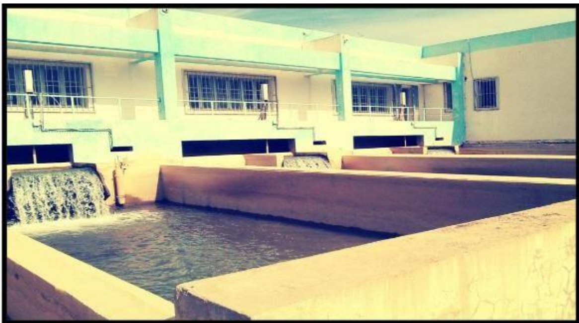
Figure II.9 : Représente le bassin de Filtration
