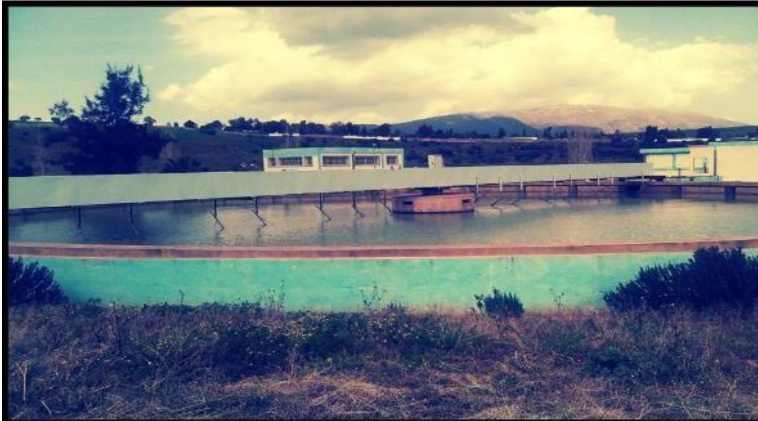
Figure II.7 : Représente le bassin de décantation
