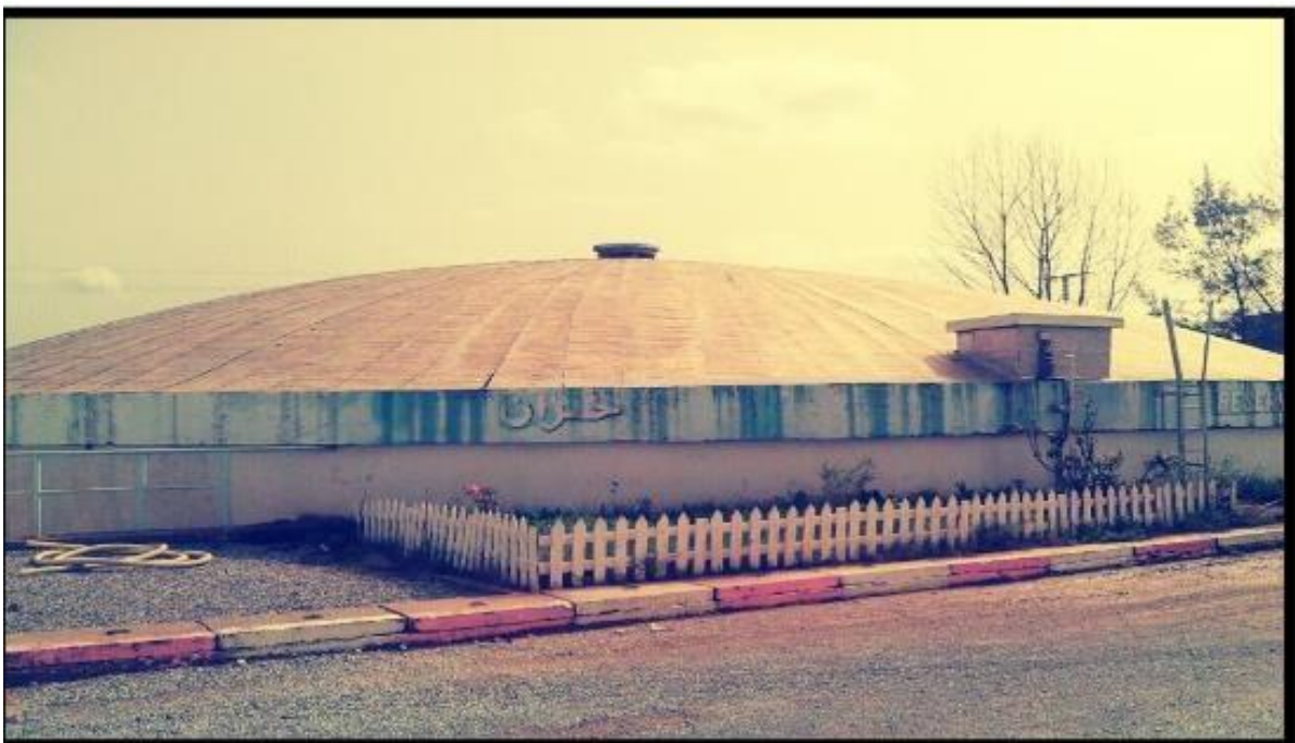
Figure II.10 : Le réservoir de stockage
