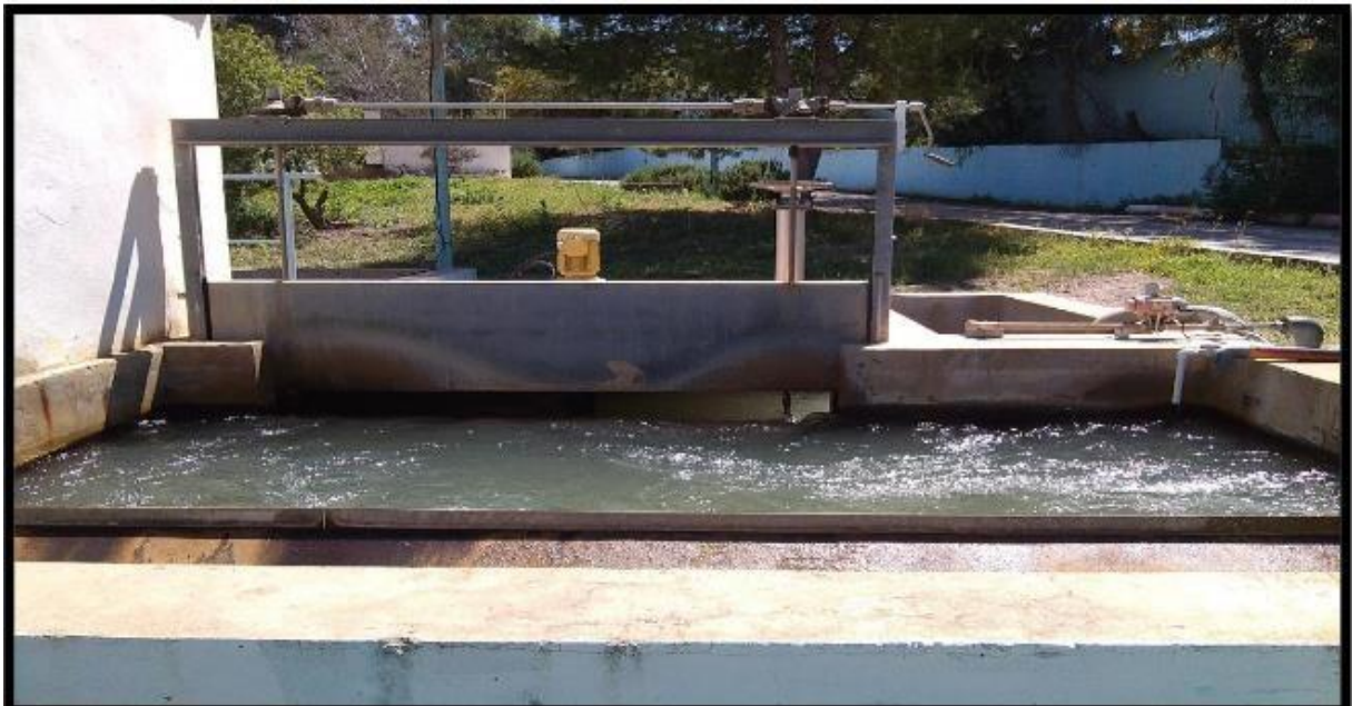
Figure II.4 : Représente le bassin de pré chloration
