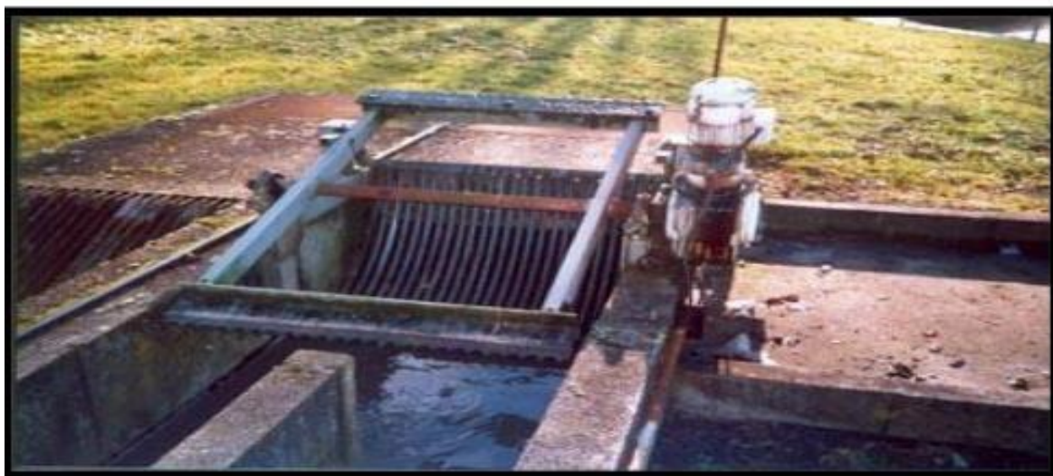
Figure II.2 : Schéma d'un dégrilleur
