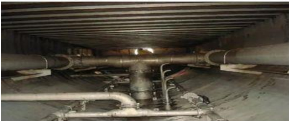
Figure. III.4. Les tuyauteries de dessaleur [12]
