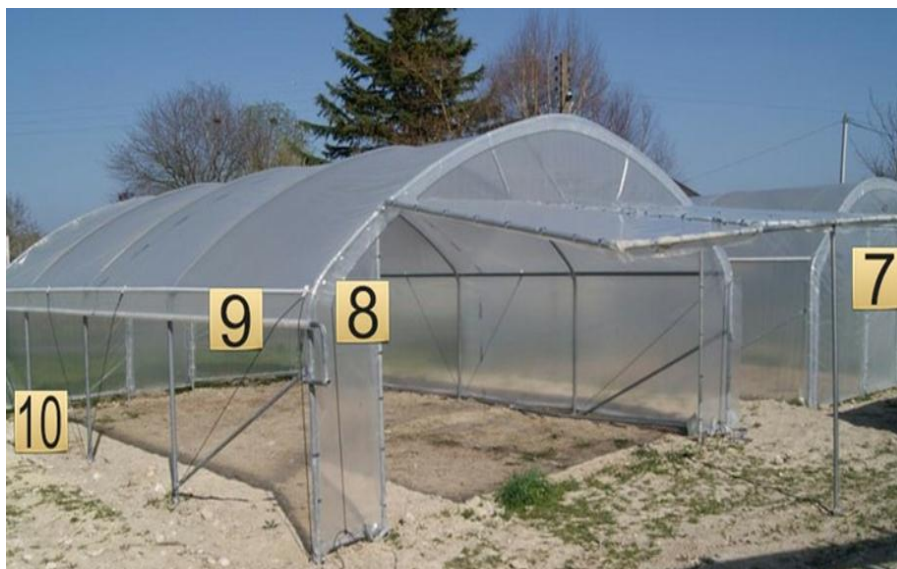
Figure N° :15 les éléments de la serre tunnel
