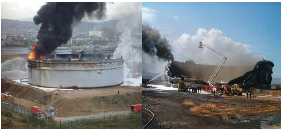
Figure 40: Bac 106 en plein feu et Bac 105 après l'accident
