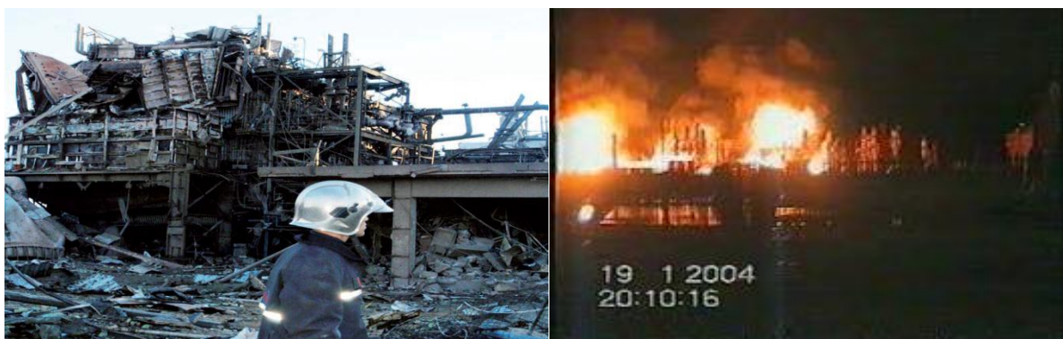
Figure 16: La catastrophe du complexe de GNL de Skikda, 2004
