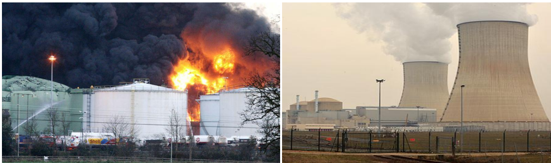
Figure 5: Exemples d'accidents majeurs
