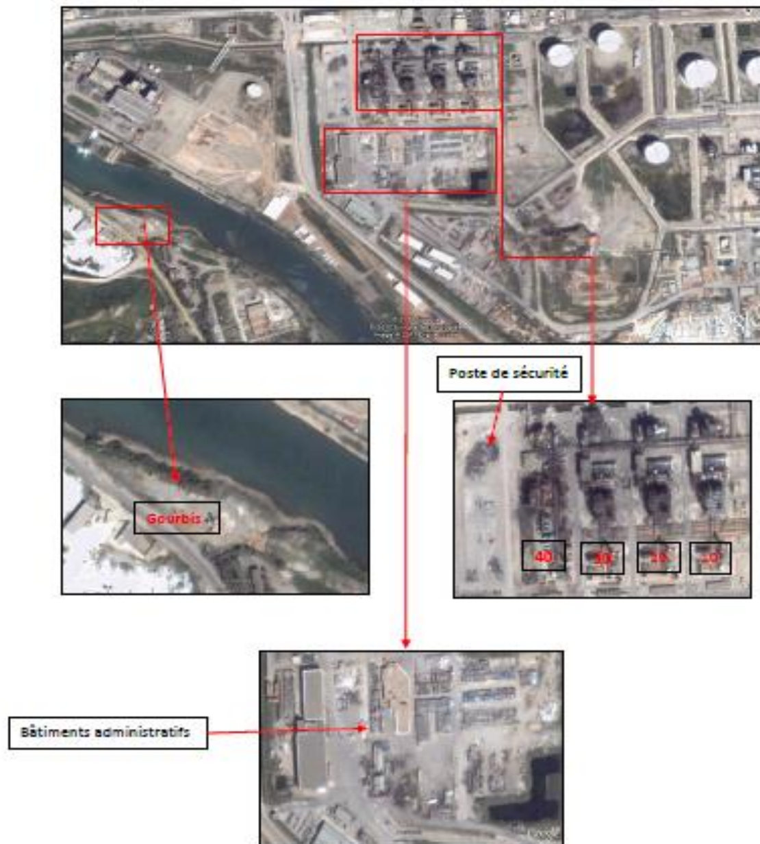
Figure 35: Site du complexe GL1K vue aérienne après explosion
