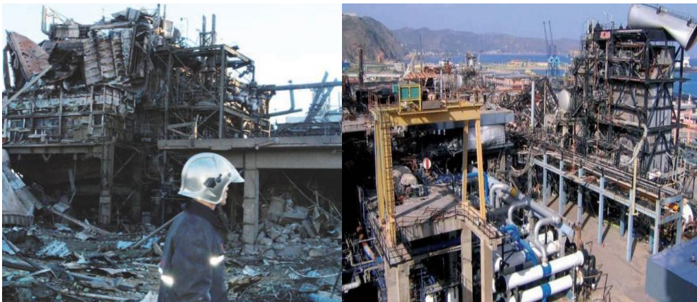
Figure 1: Dégât causé par l'explosion du GNL de Skikda 20 janvier 2004
