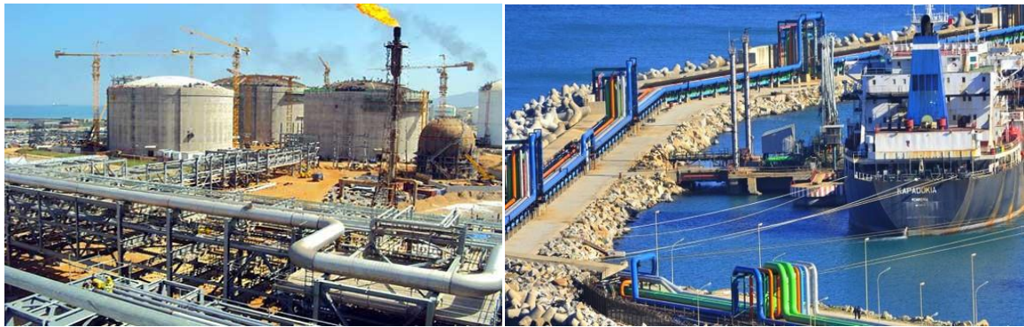
Figure 30: Complexe du GNL à Skikda
