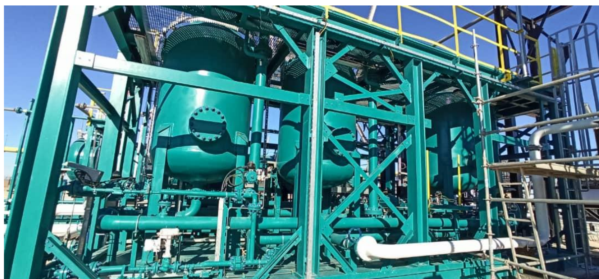
Figure.III.6 : Les filtres à coquille de noix (Nutshell).
