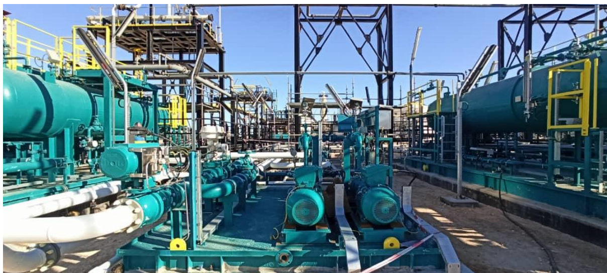
Figure.III.4 :L'unité de flottation par gaz induit.
