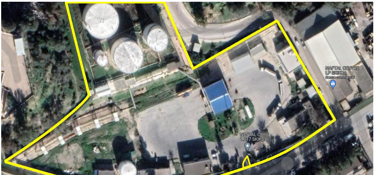
Figure II.5. Localisation de post chargement CBR 1217.
