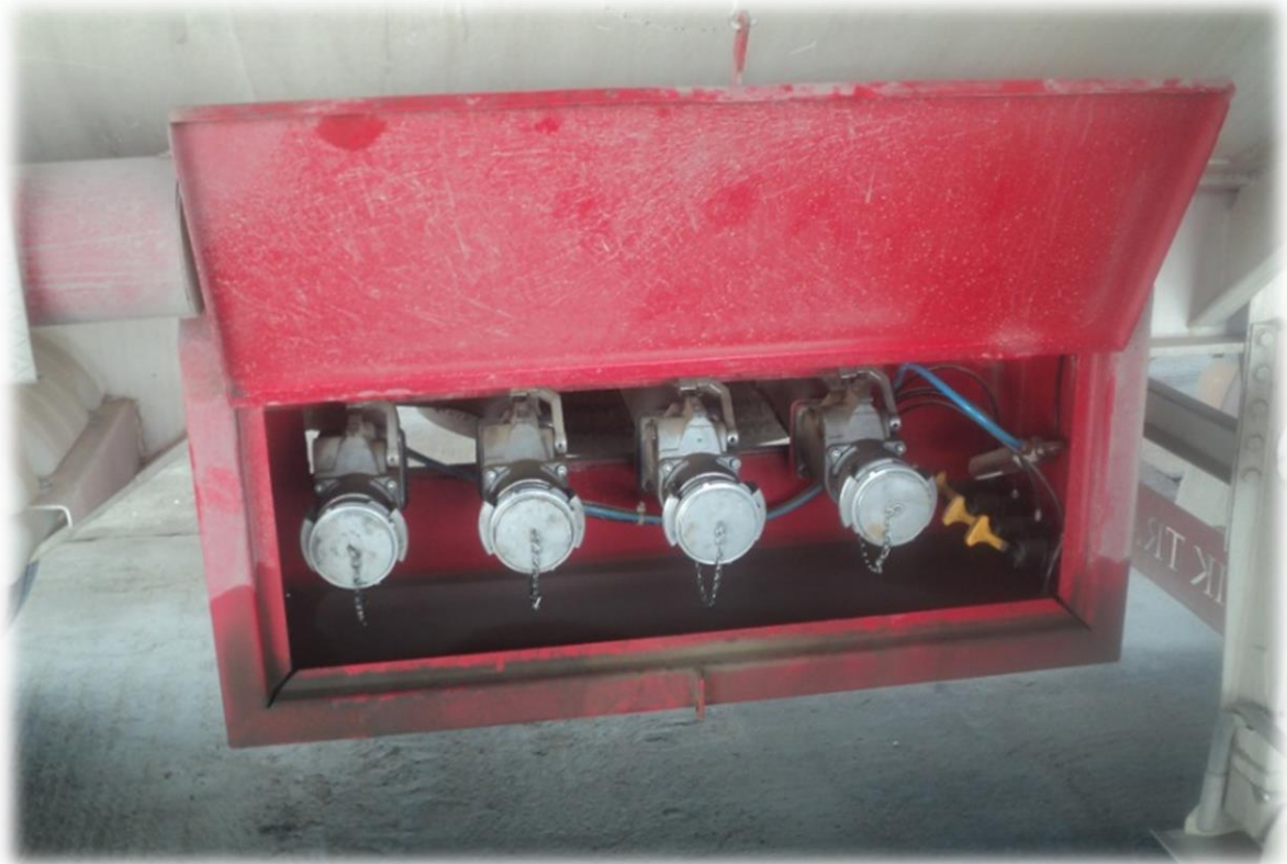
Figure : Les vannes de potage.
