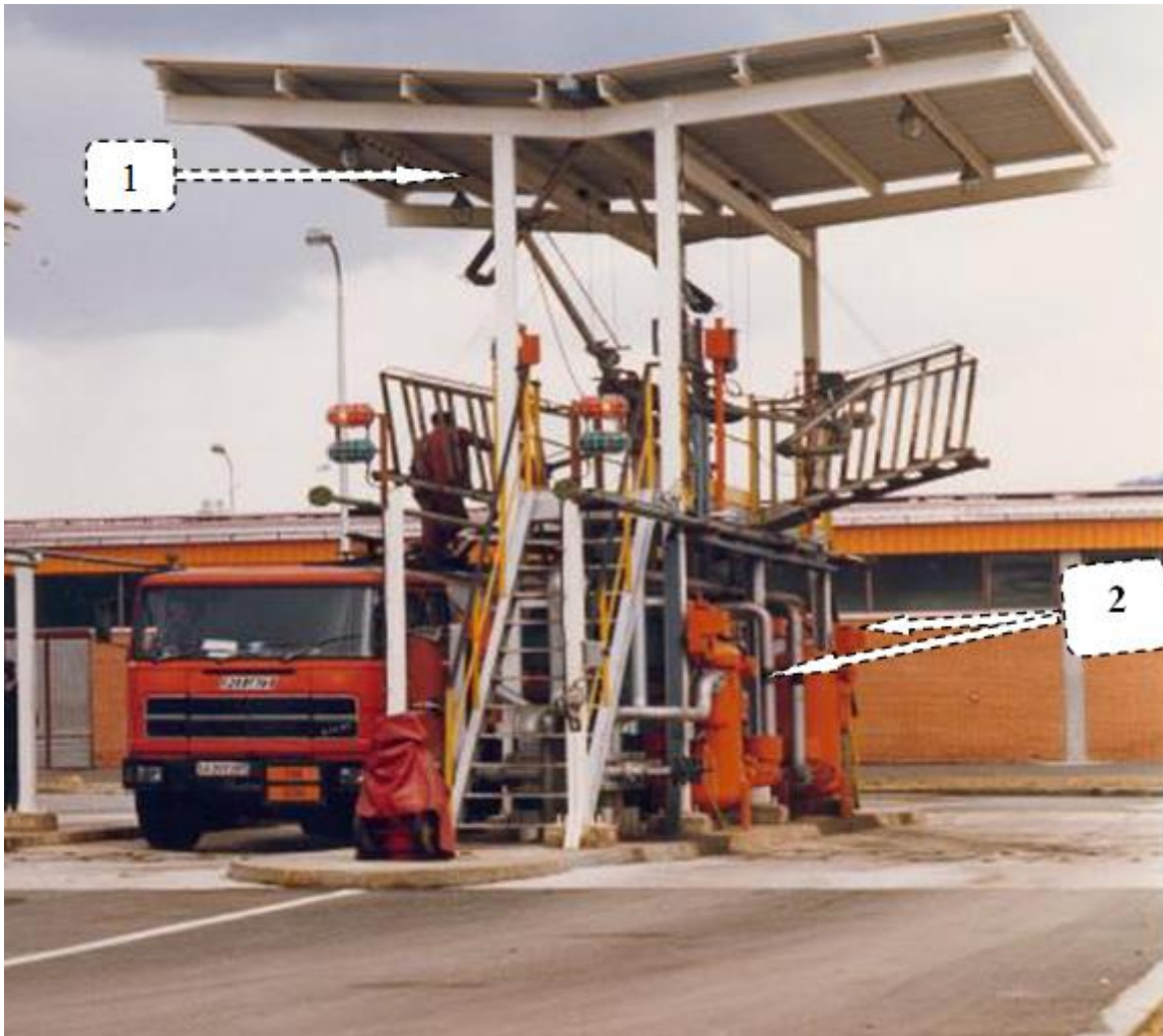
Figure II.8. Post De Chargement Par Le Haut [25].
