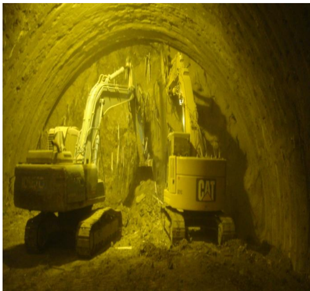
Figure 4.8: Excavation de la demi-section supérieure (Tunnel T4 –Algérie-)
