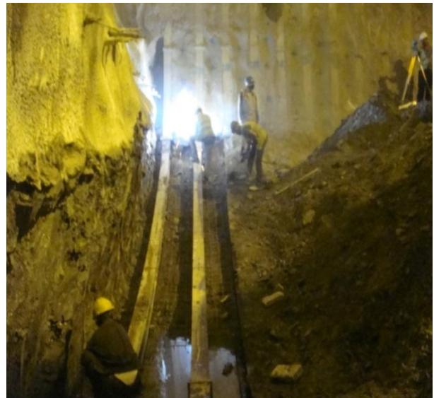
Figure 4.11: Mise en place du soutènement (radier temporaire)
