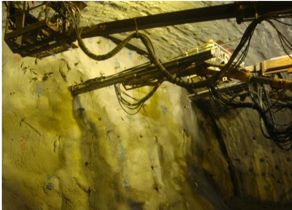
Figure 4.7 : Réalisation du boulonnage frontal par tubes « GFRP » (Tunnel T4 –Algérie-).
