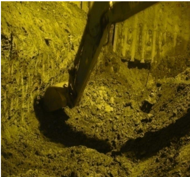
Figure 4.10: Excavation de la demi-section inférieure
