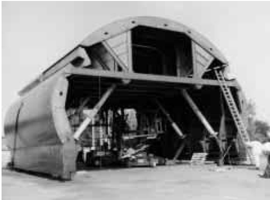
Figure 1.6 : Coffrage métallique de tunnel (Doc. de CETU)
