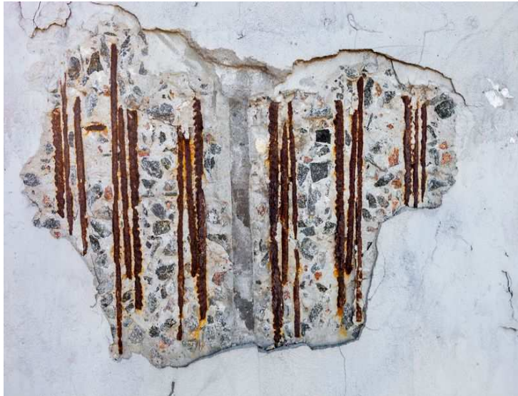
Figure I.2: Effet des agressions sur les armatures [6].
