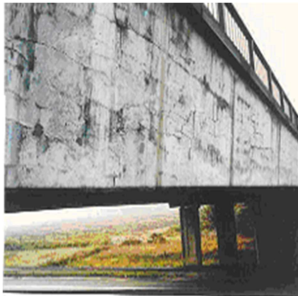
Figure I.1: Effet des milieux agressifs sur les bétons [4].
