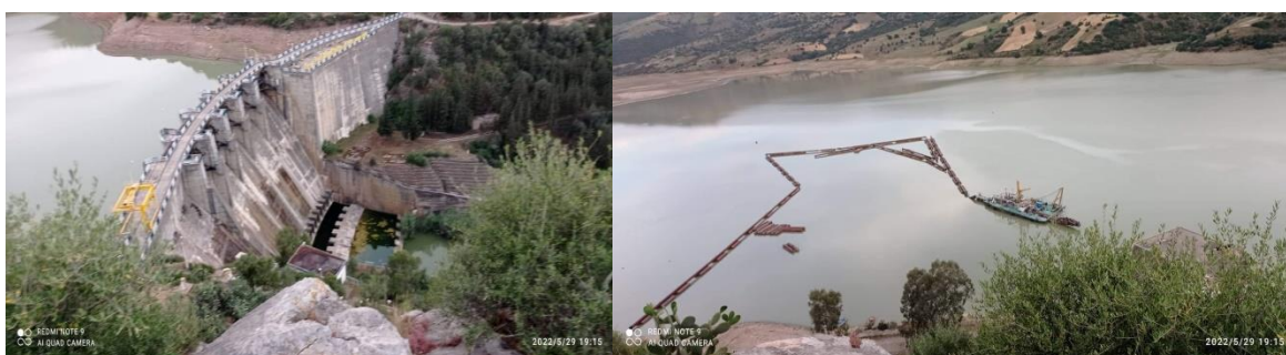
Figure 6: Barrage Zerdazas El Harrouche.
