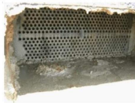
Figure II.12: Dépôt salin bactérien [13].
