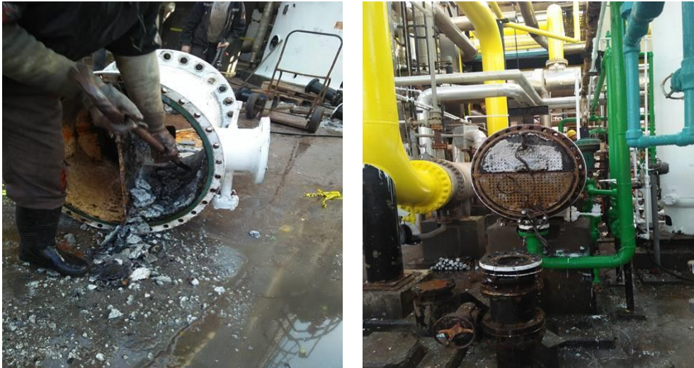
Figure II.16: Bouchage des tubes d'un échangeur [29].
