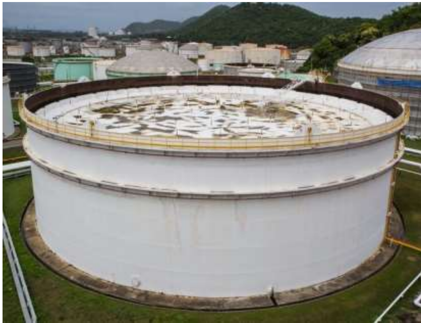
Figure I.4: Le réservoir à toit flottant
