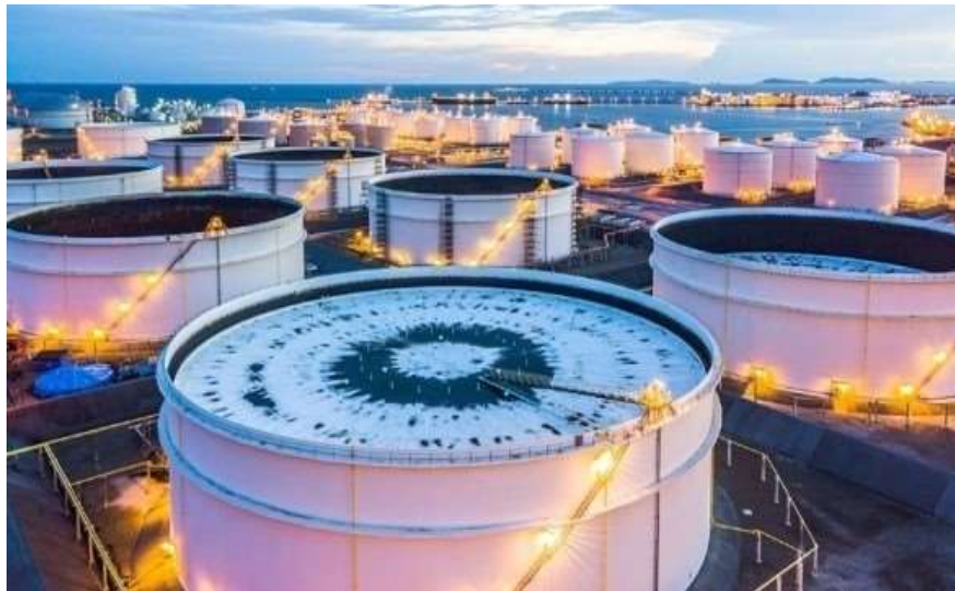
Figure I.2 : Les réservoirs de stockage
