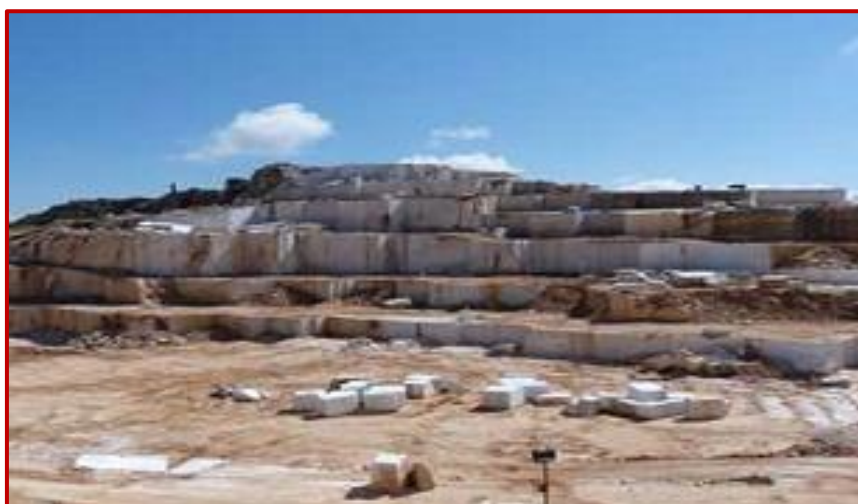
Figure I-15: Carrière à blocs de Fil-fila
