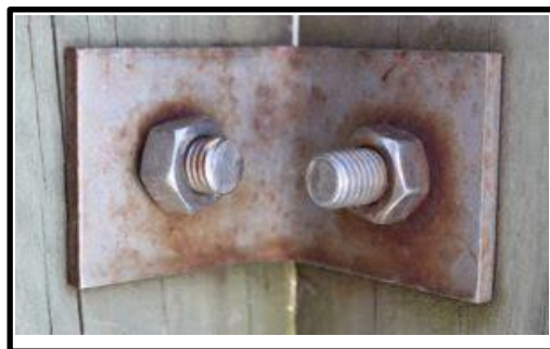
Figure I.10. La corrosion galvanique.
