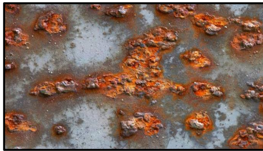
Figure I.7. La corrosion inter granulaire.
