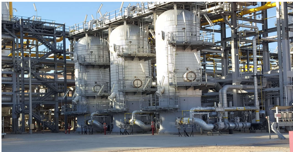
Figure III. 3. Unité de traitement de gaz « Déshydratation » (Sécheurs A/B/C). [1].
