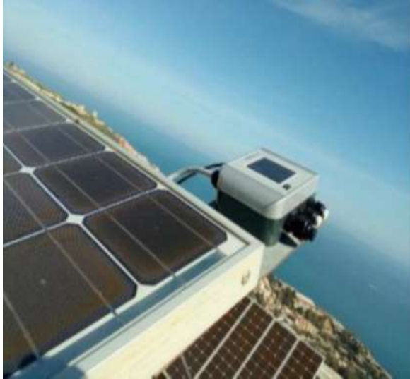
Figure A.10 : Fixation de la Sunny Sensorbox
