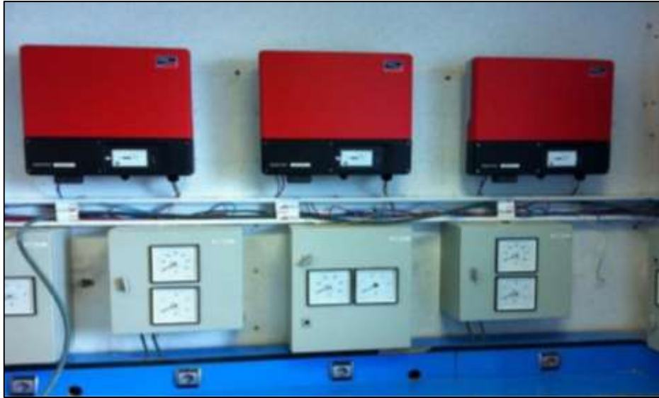
Figure A.9 : Câblage des onduleurs
