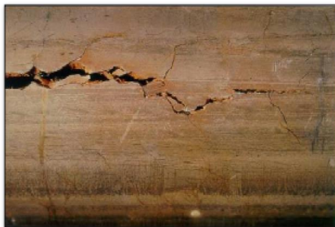
Figure I.10: Corrosion sous contrainte d'un tube en acier inoxydable en présence de quelques ppm de chlorure [32].
