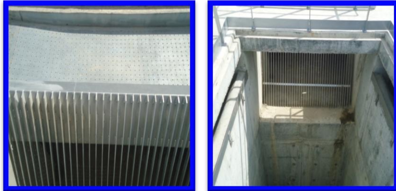
Figure IV.7. Dégrillage Grossier
