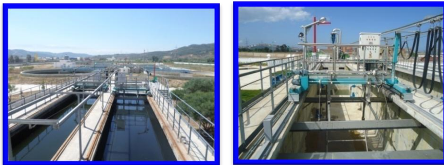
Figure IV.9. Dessablage & Déshuilage
