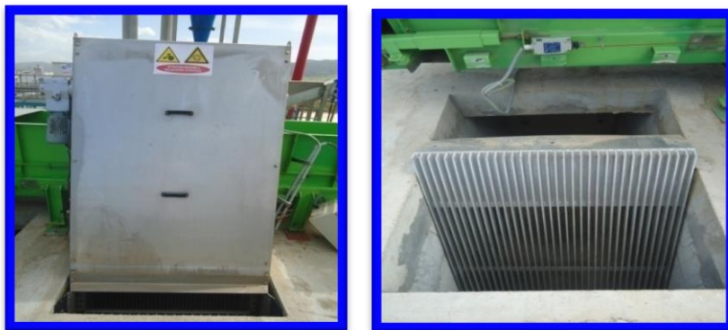
Figure IV.8. Dégrillage Fin
