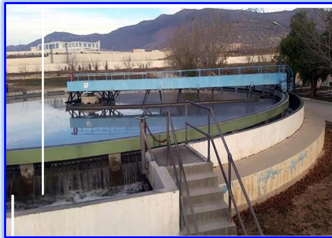
Figure II.09. Photo des décanteurs primaires
