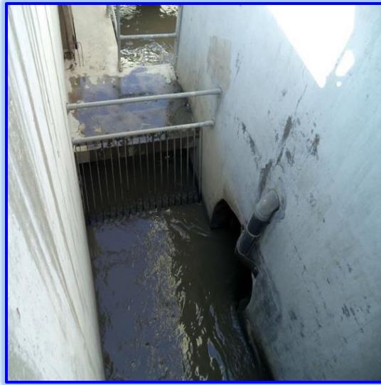
Figure II.04. Photo Pré-dégrillage grossier
