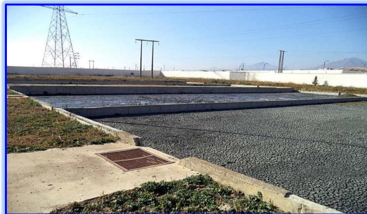
Figure II.17. Photo des lits de séchage des boues
