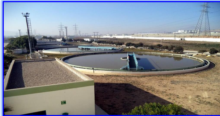
Figure II.11. Décanteurs secondaires (Clarificateurs)
