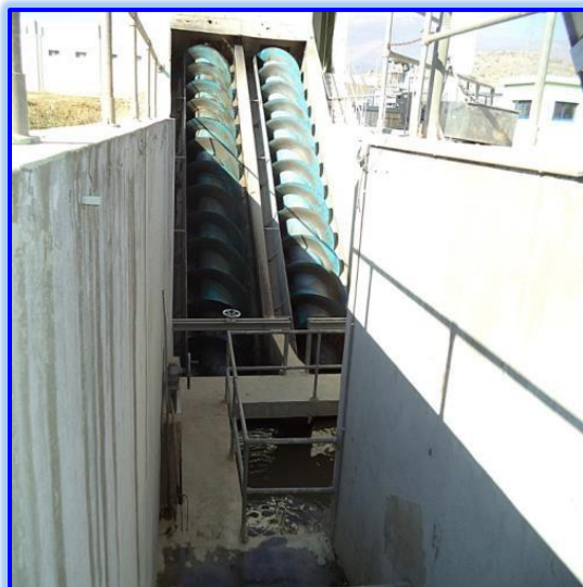
Figure II.05. Photo vis d'Archimède
