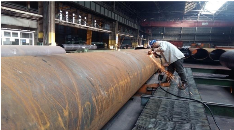
Figure.I.4 : Réparation des défauts manuellement [10].
