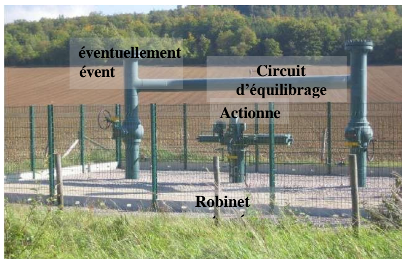
Figure I.5: postes de sectionnement [12].
