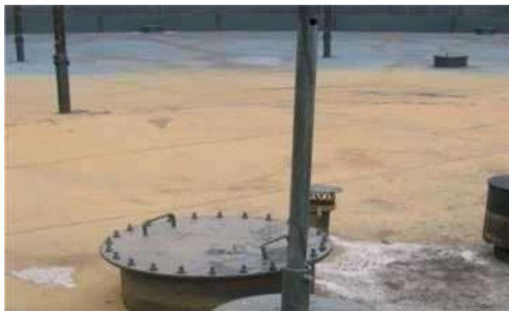
Figure III – 14 Exemple d'un trou d'homme sur le toit
