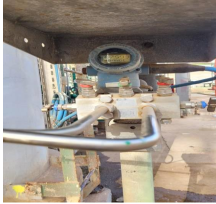
Figure II.1.1 : Transmetteur de niveau
