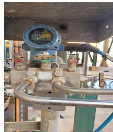
Figure II.1.1 : Transmetteur de pression
