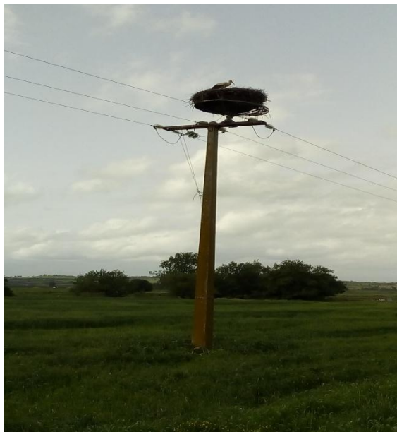
Photo A2. Un nid de la Cigogne blanche placé sur une plateforme artificielle métallique installée sur un poteau électrique en béton, localisé dans un champ de céréales (Guerbes-Sanhadja, secteur de Berrahal, Annaba, avril 2018).
