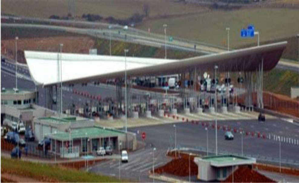
Figure I. 3: Vue d'ensemble de la couverture du péage du Viaduc de Millau.
