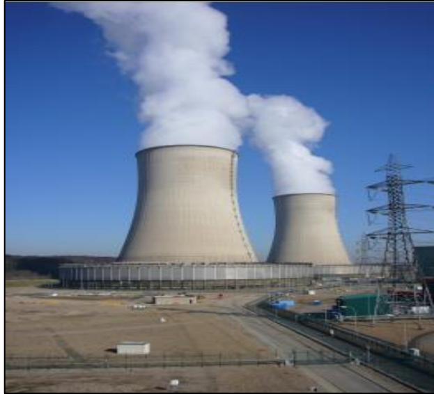
Figure I.1: Centrale de Cattenom (les aéroréfrigérants à courants croisés)
