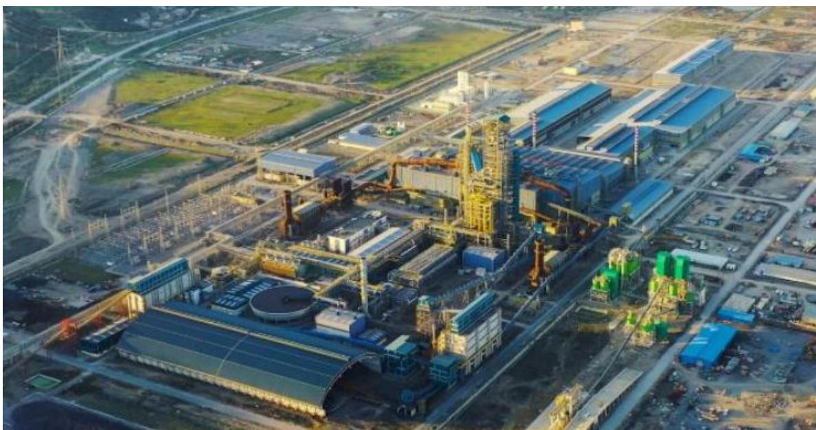
Figure 3.1. Vue du complexe[37].
