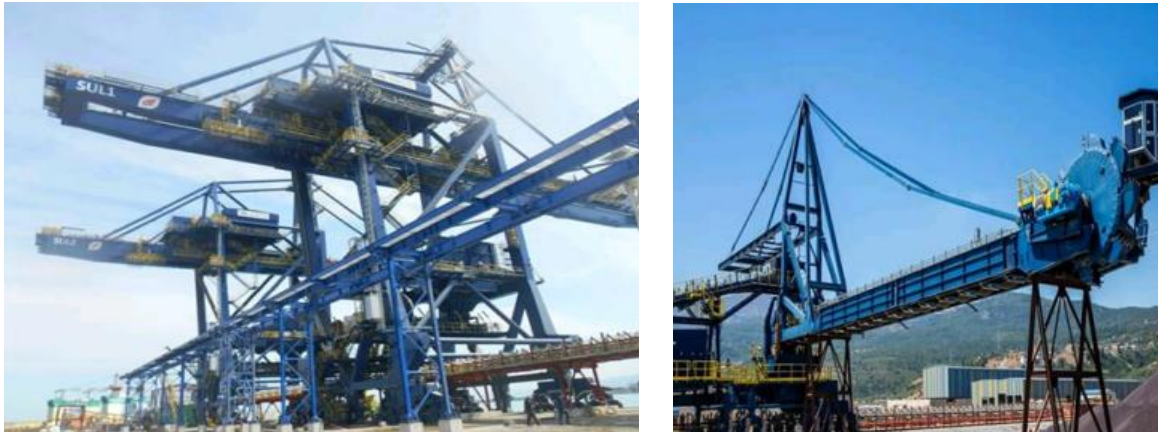
Figure 3.16. Station de récupération et de transport des matières premières [43].
