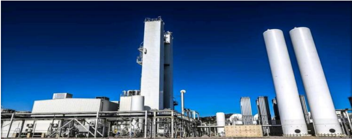
Figure 3.14. L'unité de séparation d'Air (ASU)[43].
