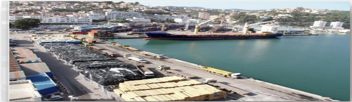
Figure 05:le terrain portuaire Point de regroupement des déchetsport
