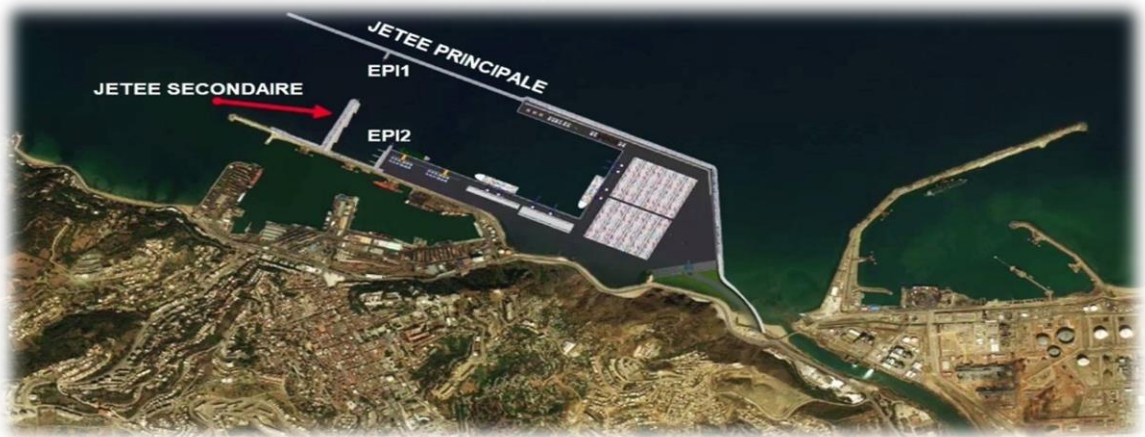
Figure 01 : la situation géographique de port maritime de wilaya de SIKKIDA
