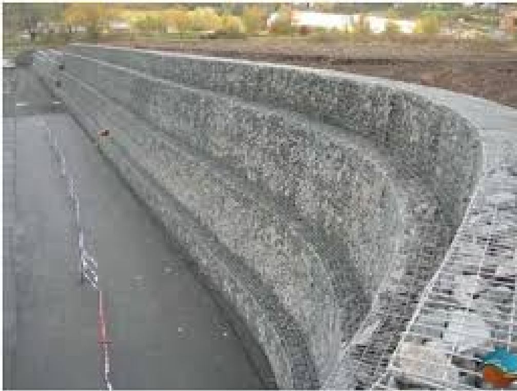
Figure 06: mur de soutènement en gabion
