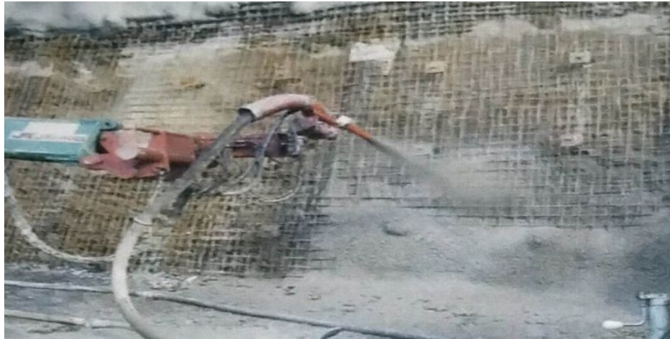
Figure 12: voile en béton projeté armé par des nappes de treillis
