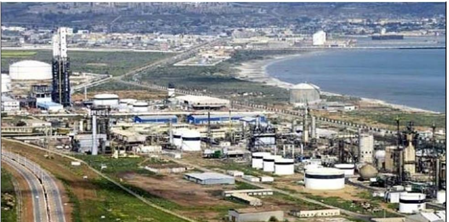
Figure 4 : Photo panoramique de la zone industrielle « SONATRACH »
