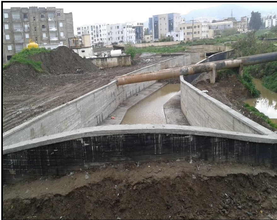
Figure 46: canal d'évacuation de l'eau pluviale. (Merdj-adibe).
