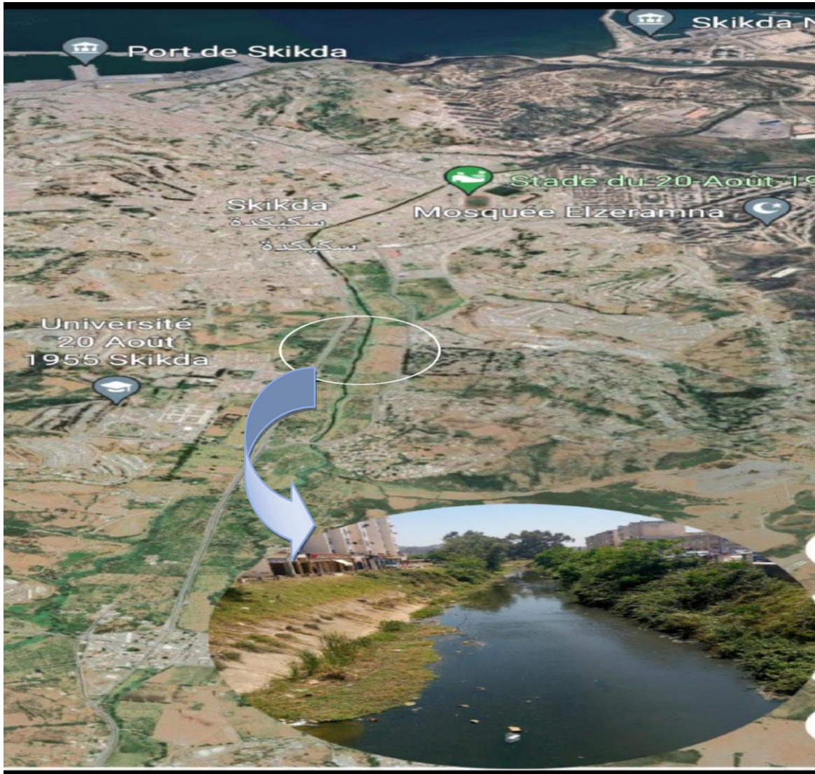
FIGURE 17 : Exemple de Pollution des eaux superficielles Oued SAF SAF
