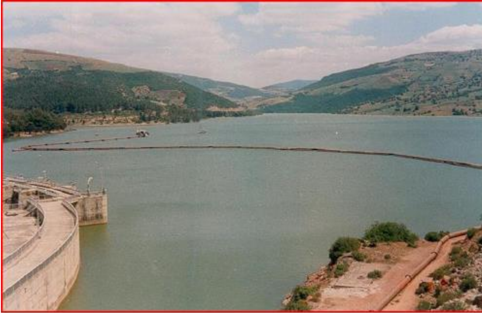
Figure 33 : Barrage de Zerdazes. [35]
