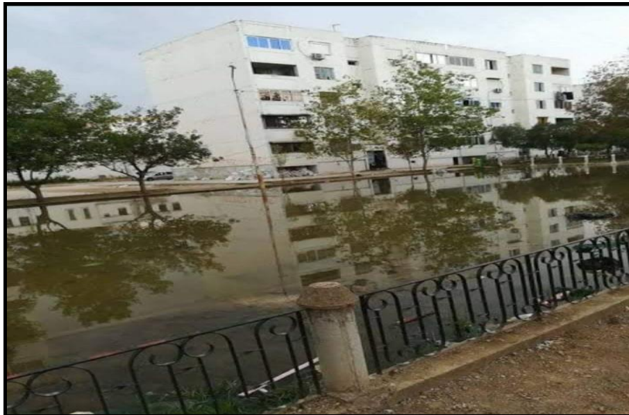
Figure 44 : inondation cité Merdj-adibe.
