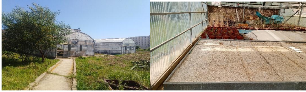
Figure 8. Vue générale de la serre (extérieure et intérieure).
