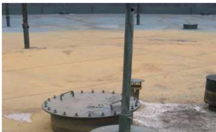
Figure III.10. : Exemple d'un trou d'homme sur le toit.
